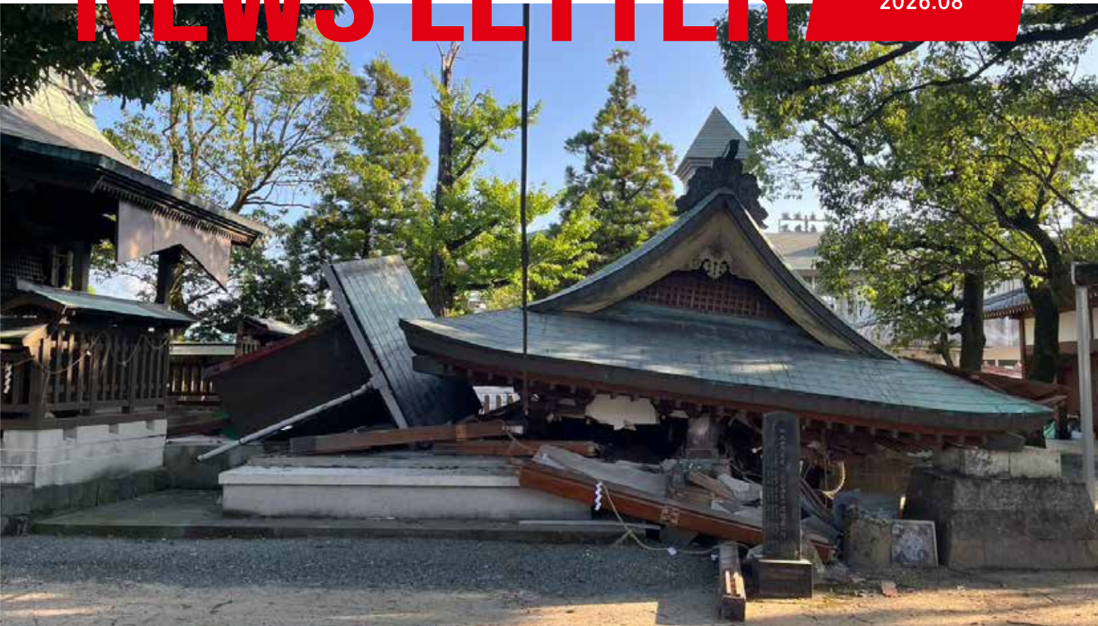
熊本県内の多くの地域で道路の寸断や家屋の倒壊、停電、断水など甚大の被害が発生（2026年7月30日撮影）
