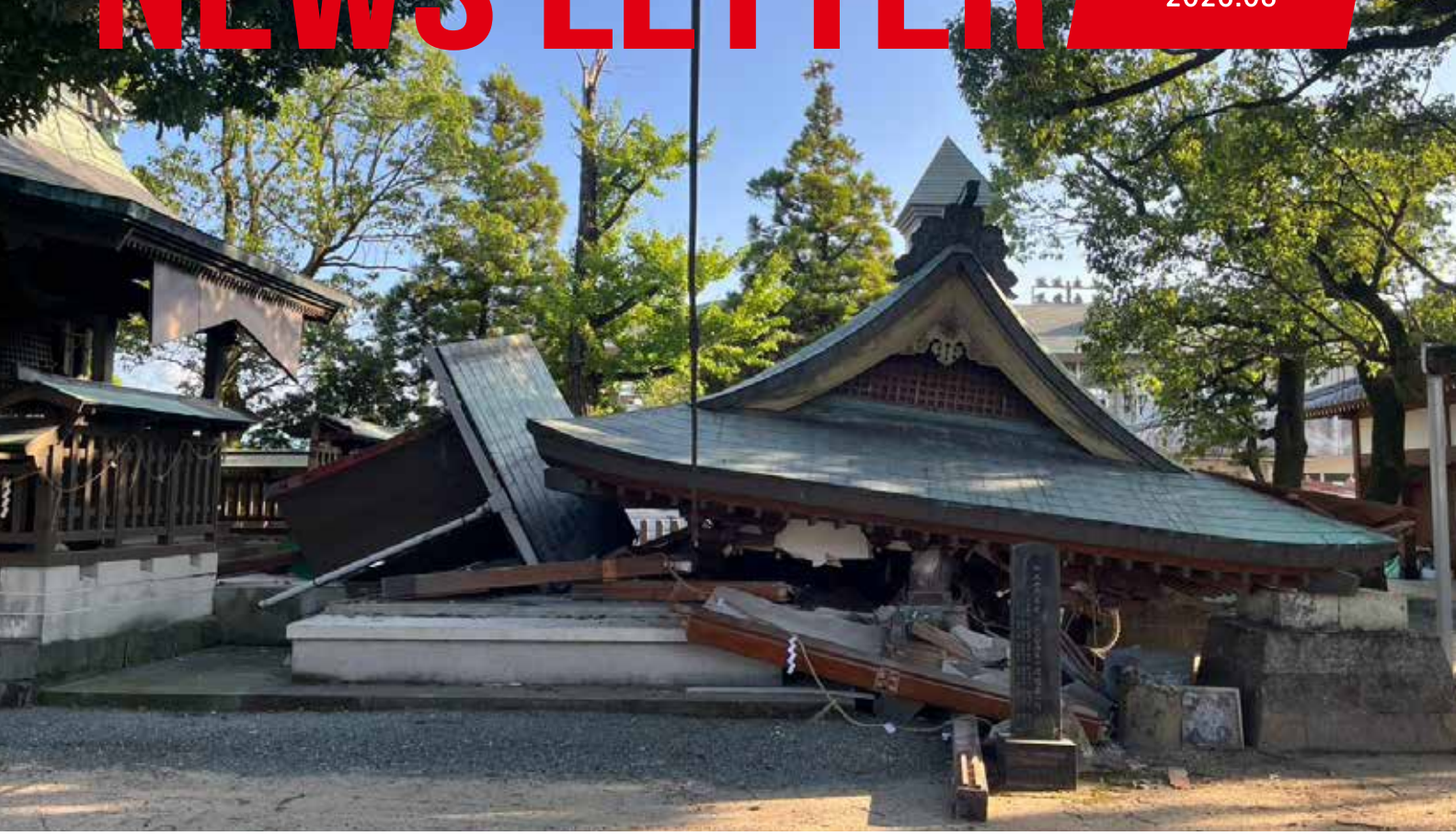
熊本県内の多くの地域で道路の寸断や家屋の倒壊、停電、断水など甚大な被害が発生(2026年7月30日撮影)
